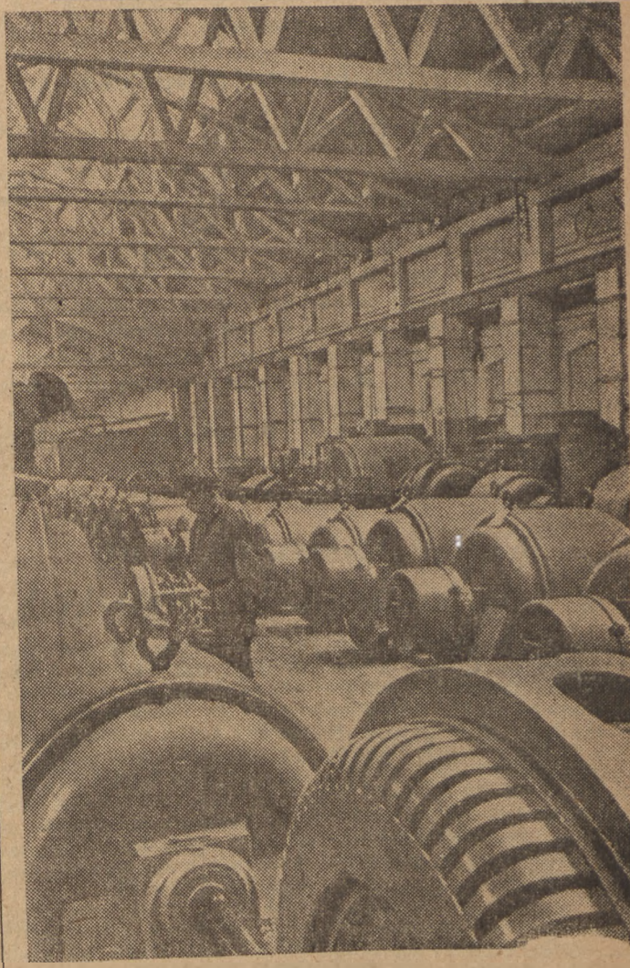
Fragment wielkiej hali nowooczesnych zakładów elektromechanicznych im. Kirowa w Minsku
