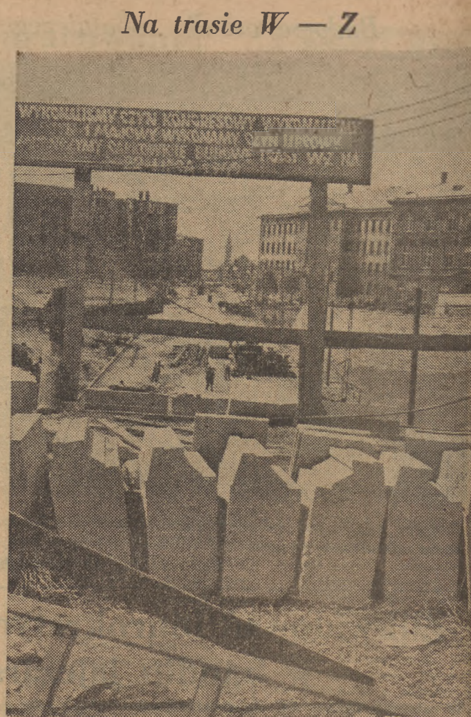
Na jednej z tablic przy trasie W-Z czytamy: „Wykonaliśmy Czyn Kongresowy, wykonaliśmy Czyn i-Majowy, wykonaliśmy Czyn Lipcowy. Zakończymy całkowicie budowę trasy W-Z na 23 lipca 1949”.
