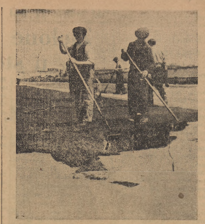
Układanie asfaltu na moście Śląsko-Dąbrowskim w Warszawie
