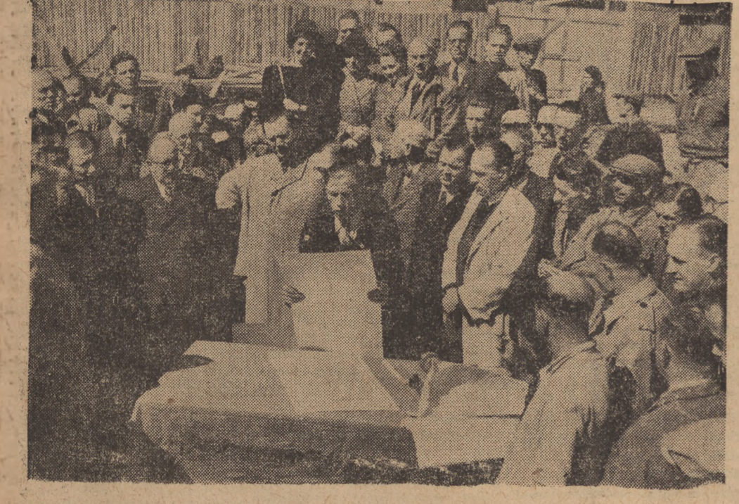
Na trawie Zamkowym w Warszawie odbyła się uroczystość wmurowania aktu erekcyjnego w fundament rekonstruowanej Kolumny Zygmunta III. W uroczystości wzięli udział pracobnicy. Na fotografii fragment uroczystości. Treść aktu erekcyjnego odczytuje pracobnik w kamieniołomów w Strzegoni, tow. Wacław Cieciura. Pracownicy tych kamieniołomów podarowali stołecy granit, z którego została wykonana Kolumna. Foto AR
