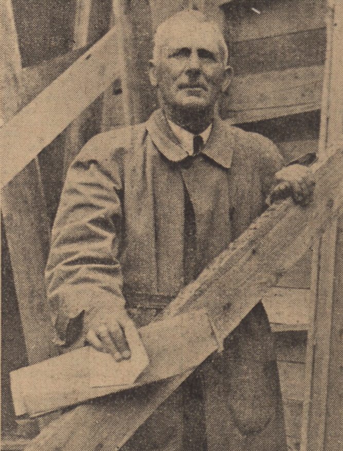
Stanislaw Michalczyk, mistrz ciesielski, pracujący przy budowie osiedla robotniczego ZOR na Młynowie w Warszawie zaprojektował nowy sposób szalowania do betonowania. Deski można wykonać — przy zastosowaniu wynalazku Michalczyka — 30-krotnie, przy czym szalowanie trwa siedmiokrotnie krócej niż dotychczas. Tak więc wynalazek Michalczyka nie tylko przyspiesza szalowanie, ale również daje olbrzymie oszczędności materiałowe.
