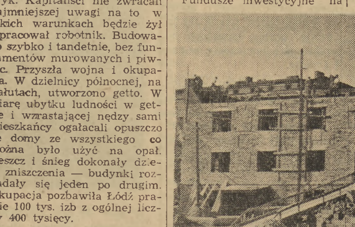
Budowa bloków mieszkaniowych ZOR przy ul. Nowo-miejskiej
