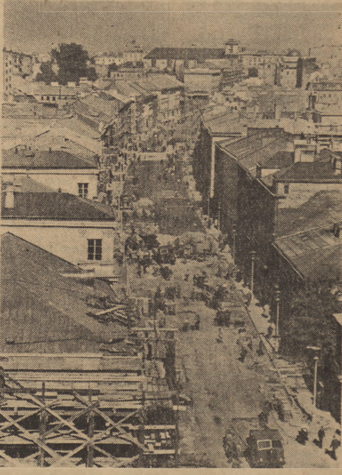
Na Nowym Świecie prowadzi się intensywne prace przy układaniu nowej nawierzchni jezdni. Ustawiono też nowe latarnie. Ulica otwarta będzie całkowicie dla ruchu kołowego dnia 8 października ka br. Foto AB
