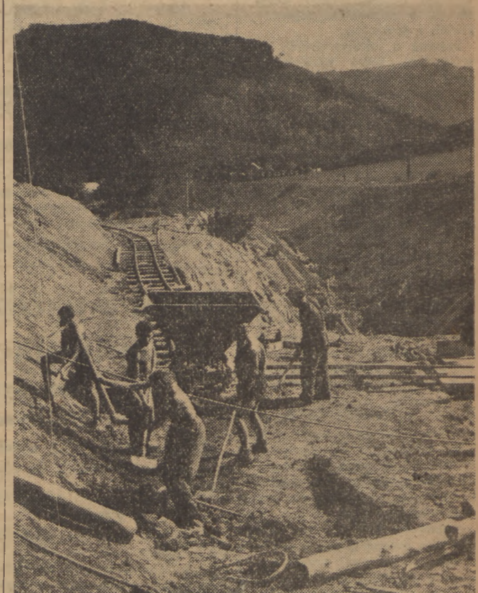
40 tysięcy młodych Czechów i Słowaków pracowało w ciągu lata w kolejnych turnusach przy budowie linii kolejowej z Hrońskiej Dubrawy do Bańskiej Szczawnicy. Prace posunęły się tak daleko, że dziś rozpoczęto już układanie torów.
