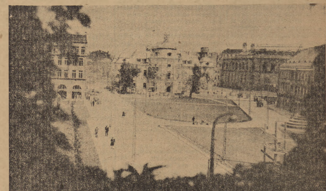
Na trasie W—Z dobiegają końca ostatnie roboty. Na zdjęciu pałac Radziwiłłowski, obecnie siedziba Związku Zawodowego Pracowników Spółdzielczych przy rozeźdleniu trasy W—Z (róg ul. Bielańskiej).
