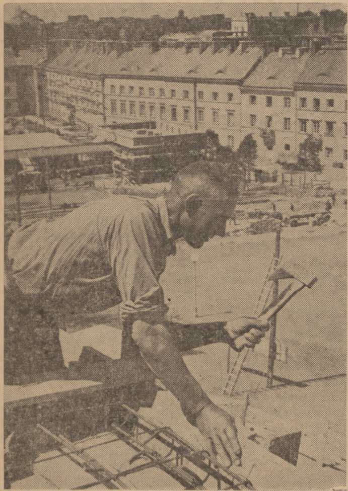
Cieśla Lewandowski pokryje niedługo dach ostatniej kamienicy na Mariensztackiej kolonii. Foto AR
