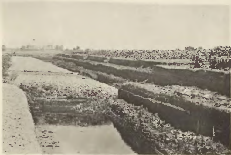
Umkühlen des Moores im Rönneleemooer. Der liegende kalkhaltige Klee wird nach oben gebracht. Rechts oben auf- gestapelter Weistorf. Foto: J. Langerfeldt-Barel. 1936
