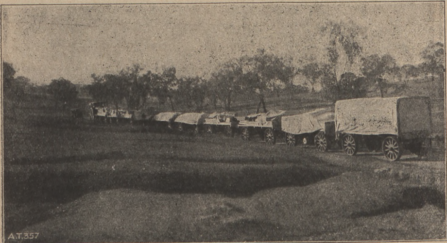
Abb. 2. Fahrt auf Lettenboden (lehmhaltig), wobei nur schwache Radeindrückung entsteht, weil die Gesamtlast auf viele Achsen gleichmäßig verteilt ist.
