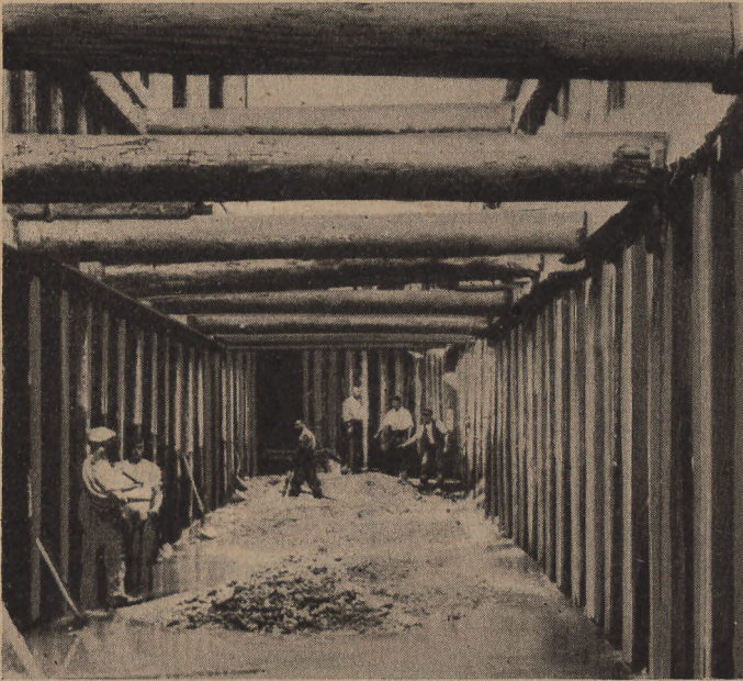
Bild 76. Spundwandbaugrube für eine Ufermauer
