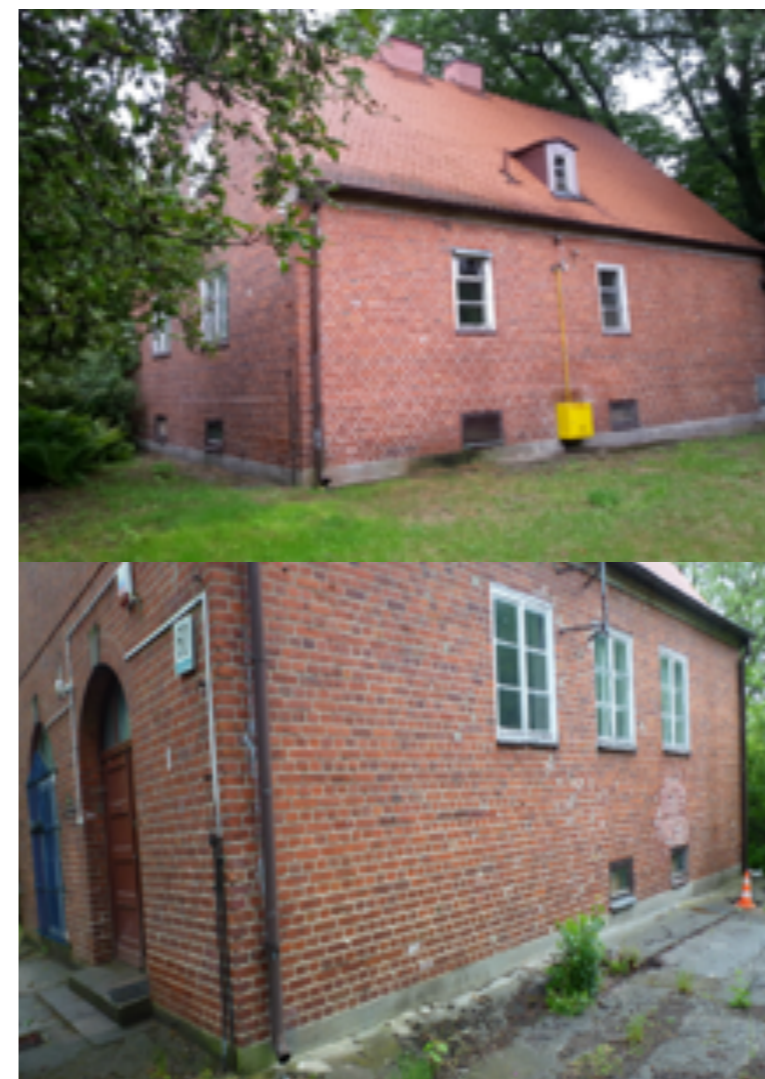
Ryc. 4. Przepompownia ścieków „Jelitkowska” – stan obecny Fig. 4. “Jelitkowska” pumping station – current state
