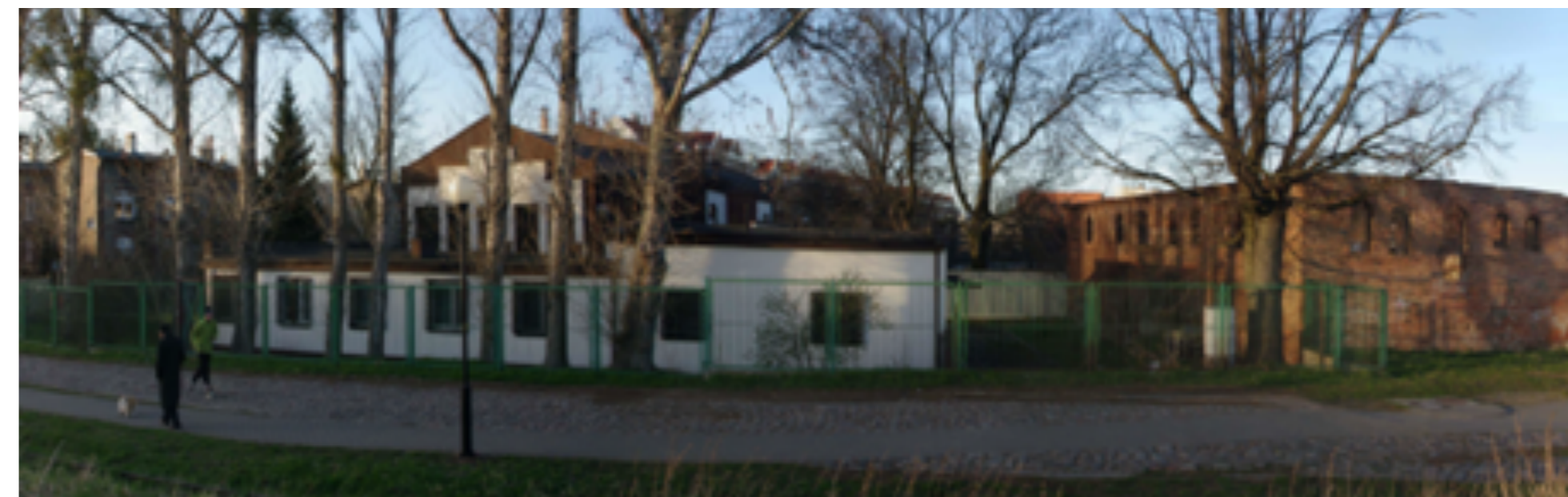
Ryc. 8. Grodza Kamienna (ruiny młyna, były budynek socjalny i były budynek stacji uzdatniania wody) Fig. 8. Grodza Kamienna (ruins of the mill, former social building and former water treatment plant)
