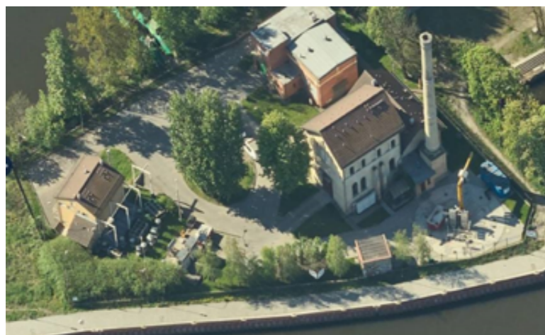
Ryc. 2. Przepompownia ścieków „Ołowianka” – stan obecny Fig. 2. “Ołowianka” pumping station – current state
