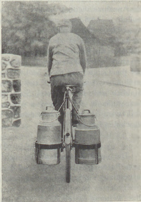
Abb. 8. Vorrichtung zur Anhängung von Milchkannen an ein Fahrrad.
