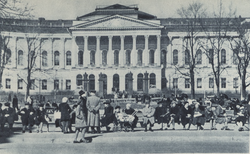
Восстановленное здание Русского музея в Ленинграде.
