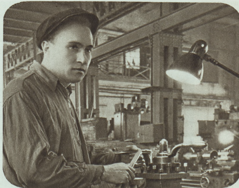
Токарь завода им. Свердлова Г. Борткевич, разработавший и внедривший в практику метод скоростного резания металла. Этот метод вчетверо-впятеро увеличил производительность труда станочников.
