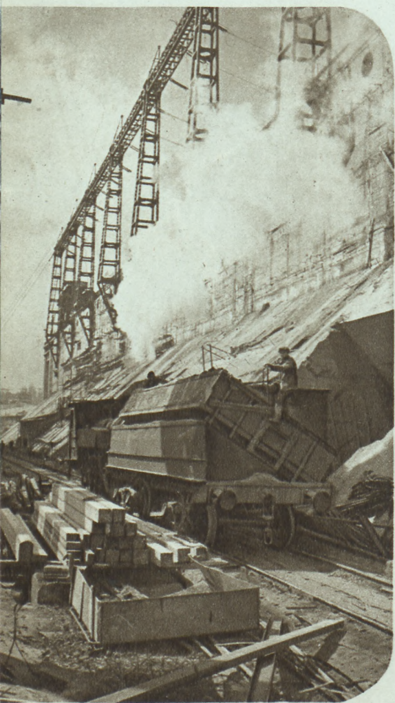
В дни восстановления Днепрогэса. Строительство щитовой стены.
