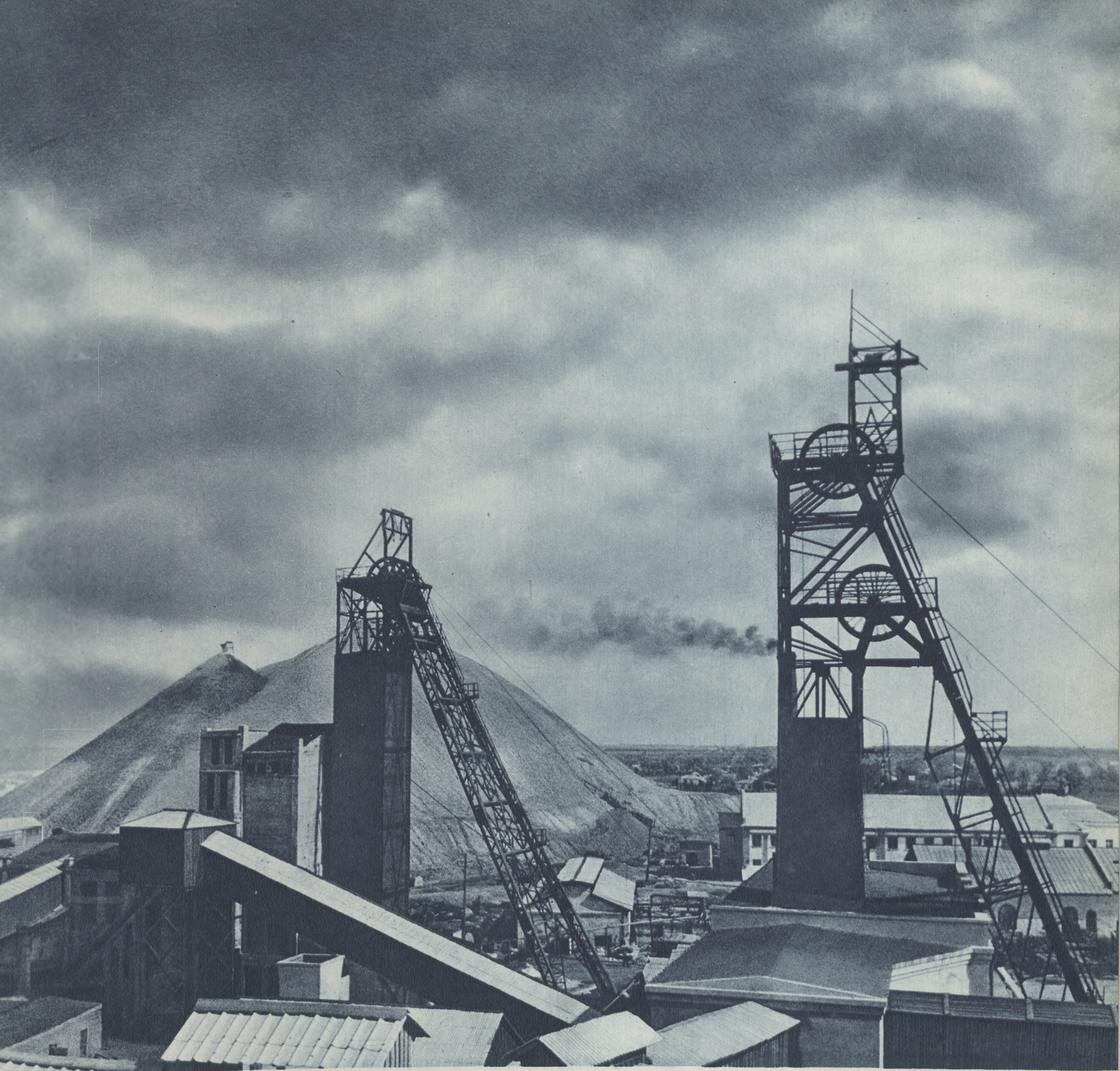
Общий вид восстановленной шахты „Лидиевка” — одной из лучших в Донецком бассейне; она уже давно перекрыла довоенный уровень угледобычи.
