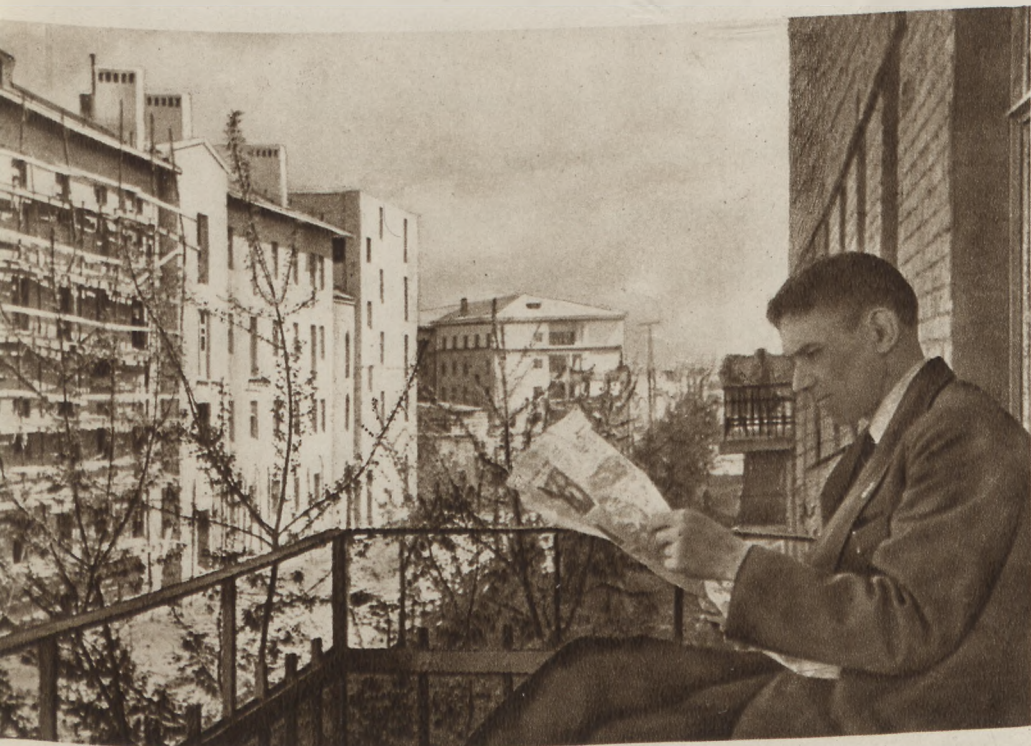
Новые дома в поселке Сталинградского тракторного завода.
