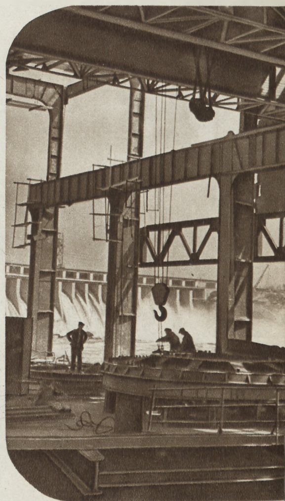
Восстановление Днепротэса. Монтаж турбин.
