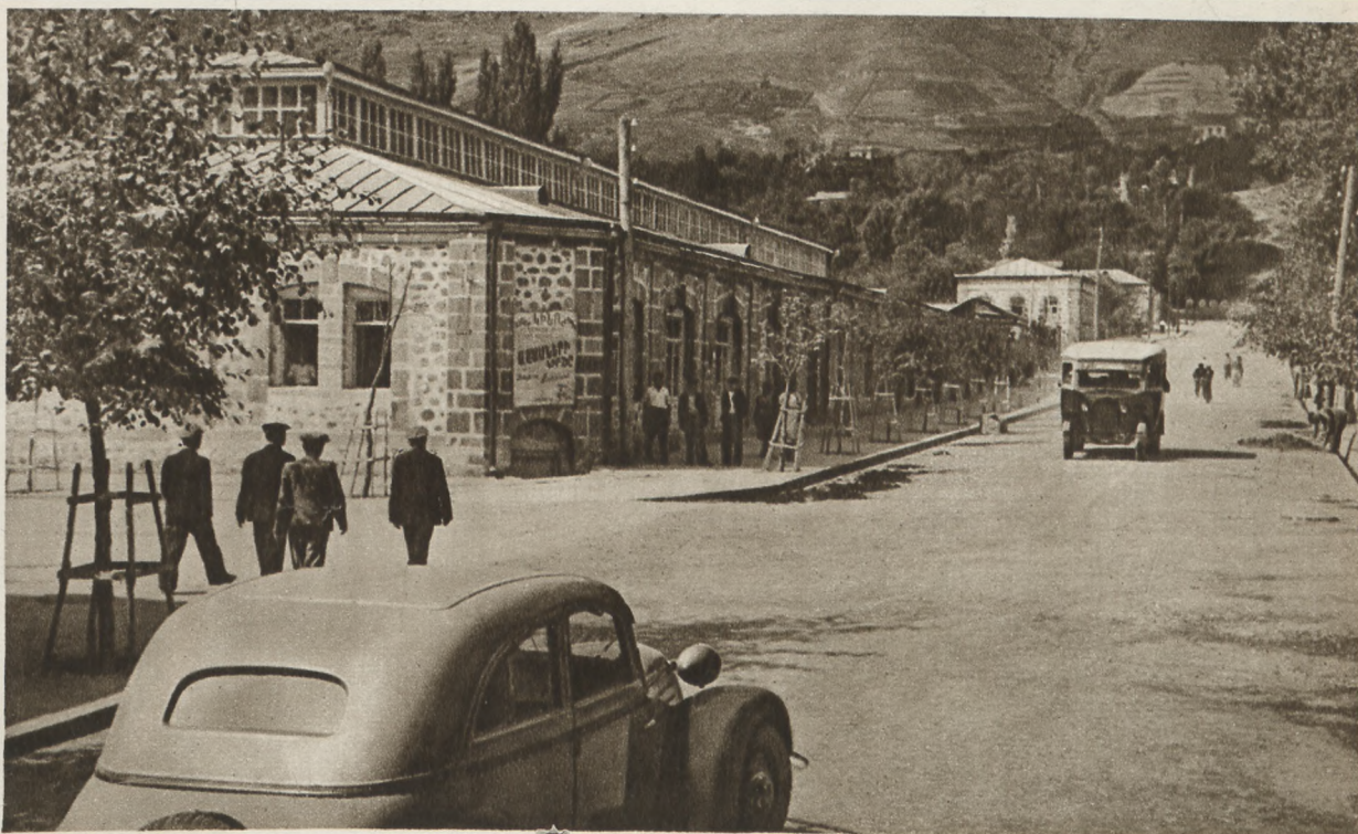
Город Горис. Здание трикотажной фабрики.
