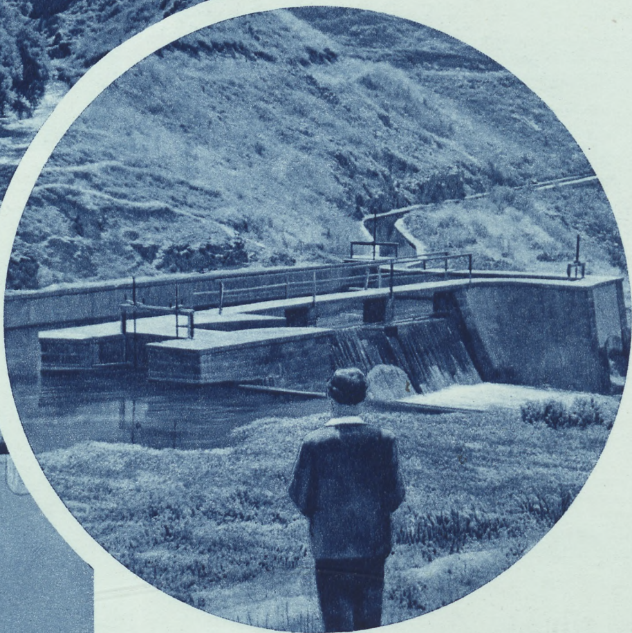
Плотина гидроэлектростанции, обуздавшая небольшую, но бурную горную речку.
