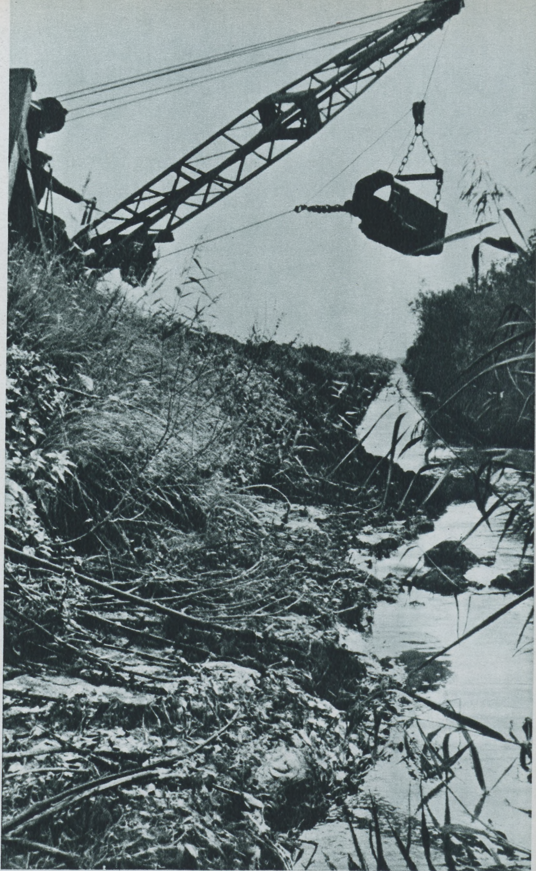
На этом снимке показан один из многочисленных экскаваторов, работающих на осушении болот в Полесье. Разветвлённая сеть каналов, вырытых экскаваторами, отводит воды с осушаемых земель.
