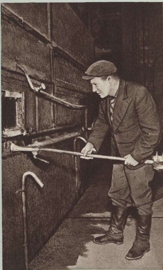
На Уральском заводе тяжелого машиностроения. Очистка литья от формовочной земли в специальных, хорошо изолированных гидрокамерах. В отличие от ручной, такая очистка значительно облегчает труд и освобождает от пыли производственные помещения литейных цехов.
