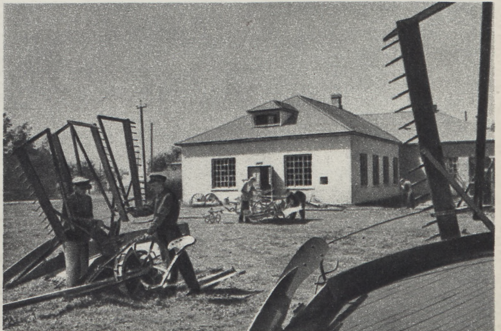
В механической мастерской колхоза ремонтируются сельскохозяйственные машины и инвентарь. На очереди — ремонт лобогреек.
