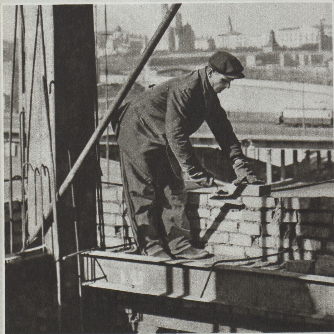
Вслед за монтажниками, сооружающими металлический каркас здания, на строительную площадку приходят каменщики, заполняющие кирпичной кладкой пролеты каркаса. На снимке — один из замечательных мастеров скоростной кладки — каменщик А. Кочубей.
