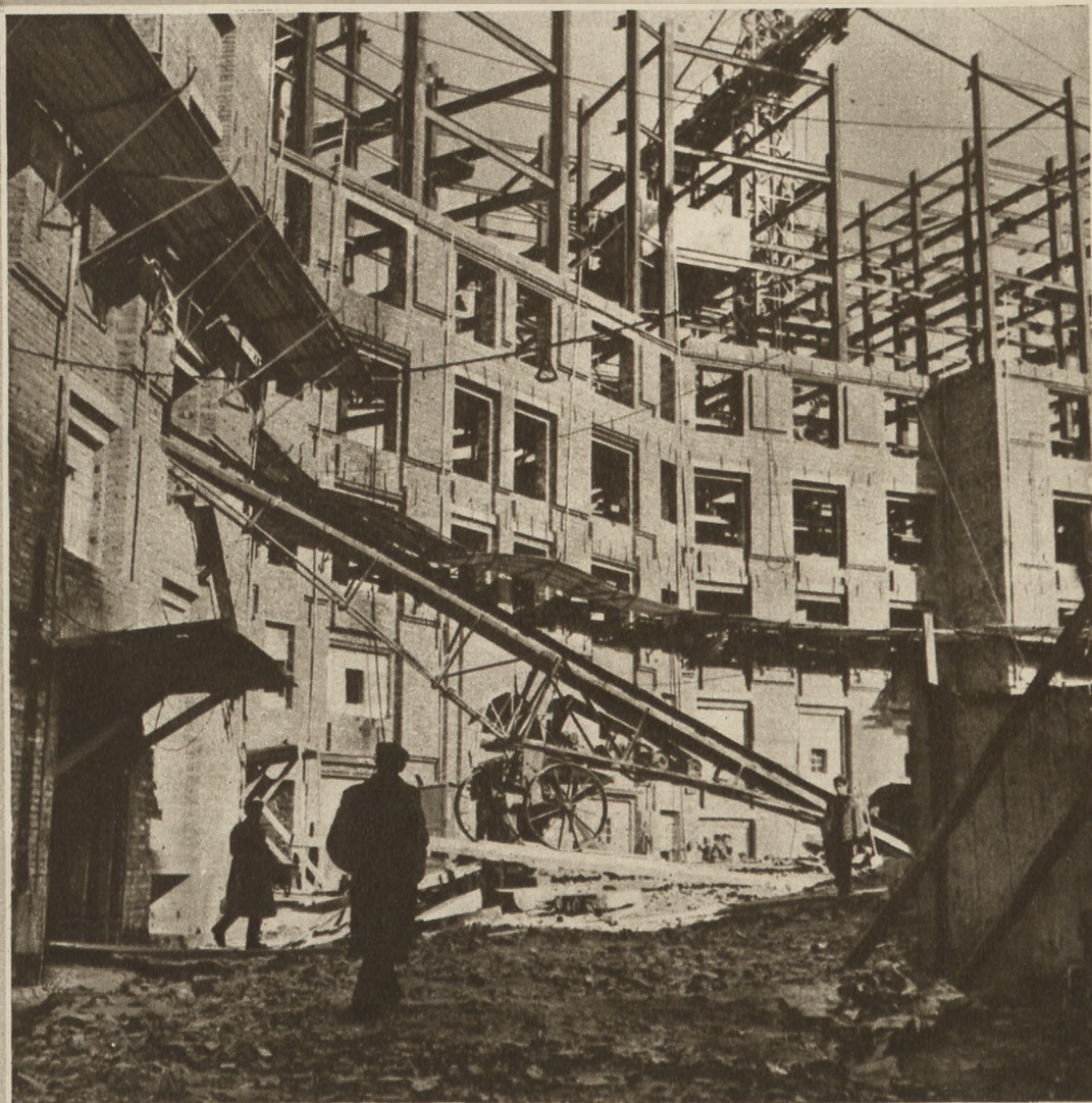
Уголок строительной площадки на Котельнической набережной. На снимке видны кирпичные стены дома, быстро растущие вслед за поднимающимся все выше металлическим каркасом. Кирпичные стены будут облицованы полированным гранитом и керамикой.
