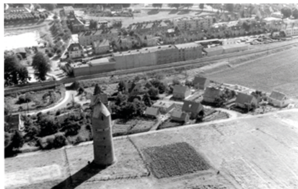
Miastko, ok 1969, widoczny dom rodzinny artysty w trakcie budowy
