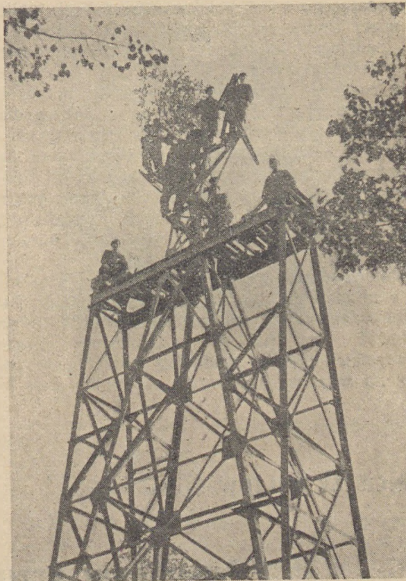
Rys. 2. Maszt kolejki linowej.
