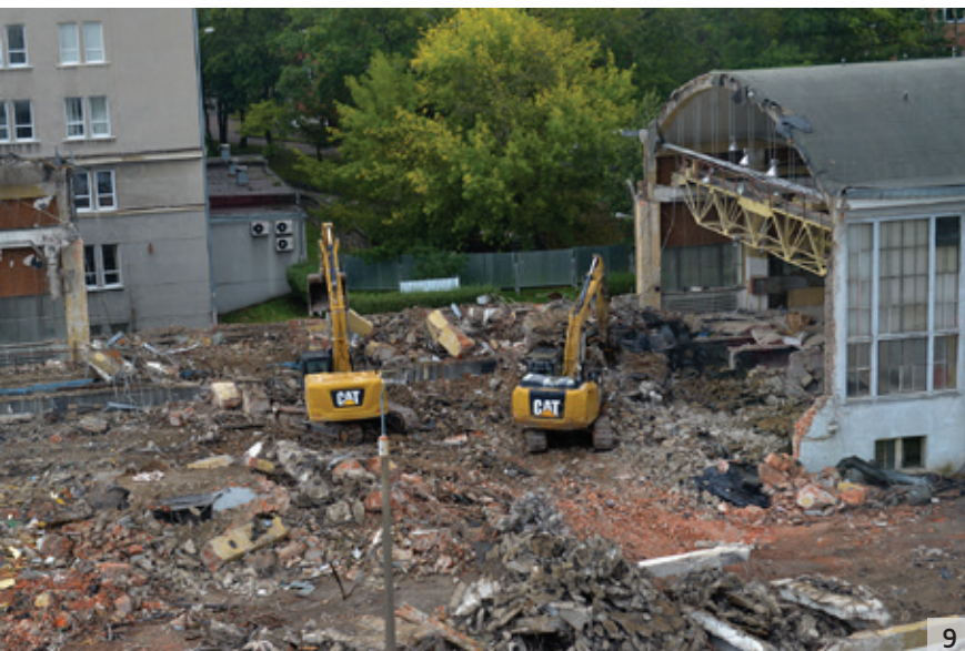
Fot. 9. Rozbiórka hali laboratoryjnej, wrzesień 2020 r.
