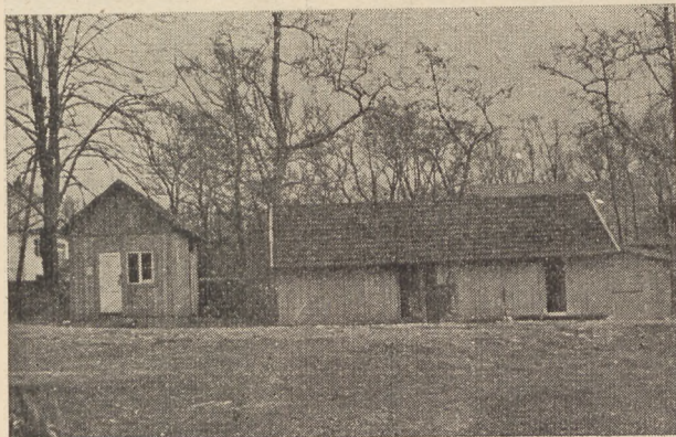
Urządzenie miejsca skupu w Peimtu, pow. Myślenice, wybudowane w drugiej połowie 1949 roku (fot. inż.
