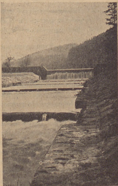
Ryc. 17. Pięciometrowy, kamienno-betonowy próg bez przepławki w nowocześnie uregulowanym korycie Leśnicy, dopływu Brennicy.
