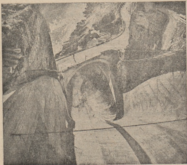
Rys. 12. Zakończenie kanału ulgi wód powodziowych na prawym brzegu.
