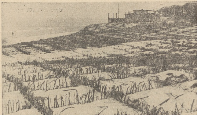
Rys. 4. Utrwalanie wydm płótkami z chrustu.
