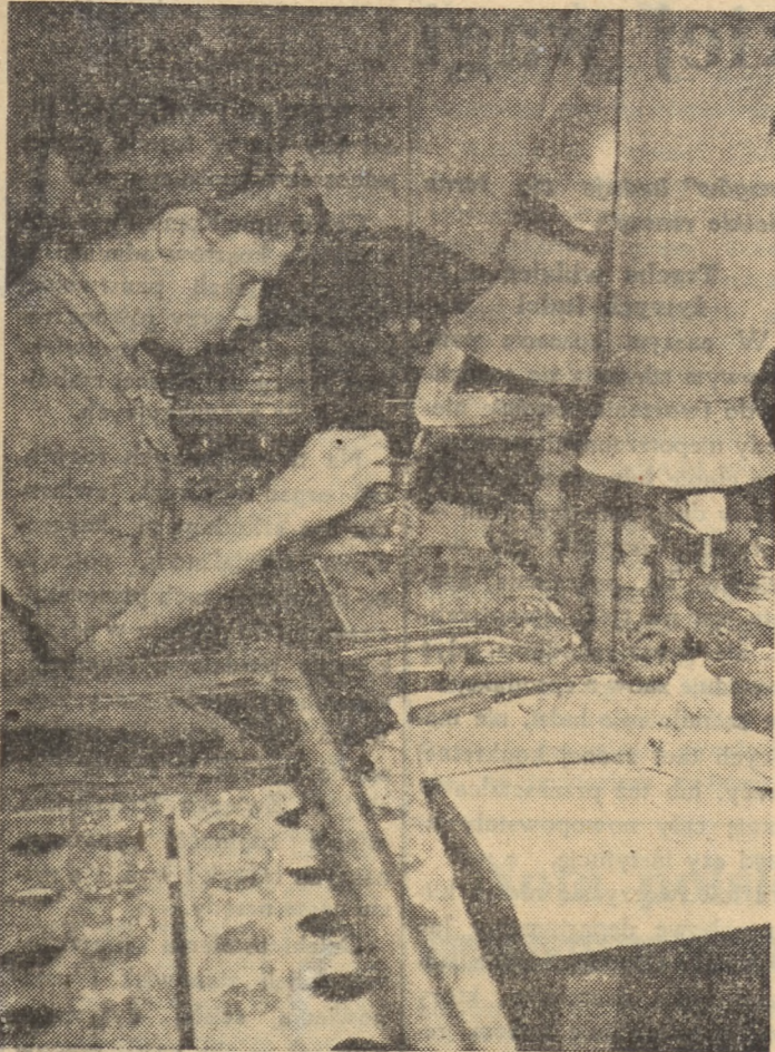
Janina Piotrowska, robotnica z warszawskiej fabryki żarówek L-3, usprawniła swoją pracę przez ulepszenie noża do obcinania elektrod. Pomysł Janiny Piotrowskiej przyniósł wiele oszczędności.
