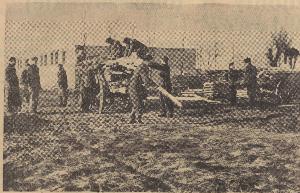
Spółdzielnia produkcyjna w Kosowie k. Bydgoszczy, powstała jesienią 1949 roku. Członkowie spółdzielni, wykorzystując okres zimowy, przeprowadzają remont narzędzi rolniczych i pracują przy stawianiu zabudowań gospodarskich. Na zdjęciu prace przy budowie obory spółdzielczej
