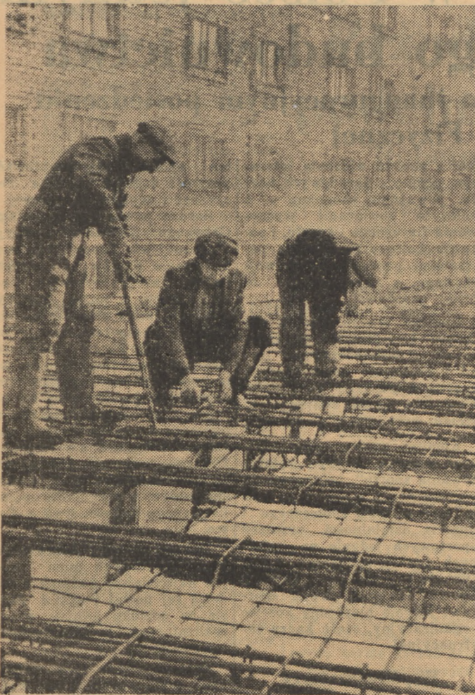
Zbrojarze Aleksander Brudziński, Józef Nowak i Antoni Nowak, zatrudnieni na budowie osiedla mieszkaniowego Muranów B. zobowiązali się wykonać w roku bieżącym po 50.000 kg zbrojeń.
