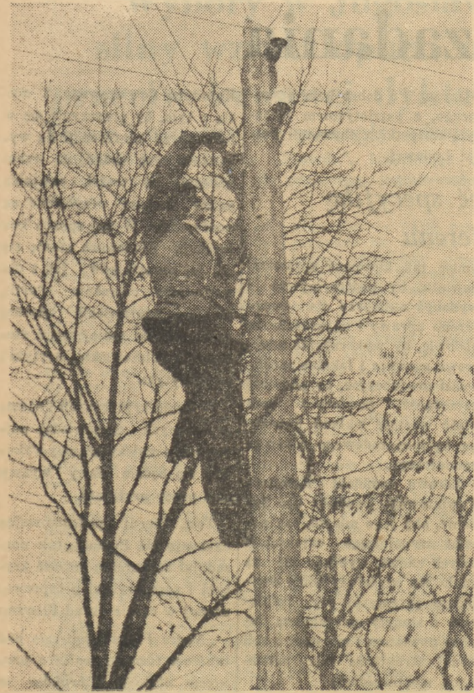
W szybkim tempie postępuje naprzód radiofonizacja wsi. Na zdjęciu: monter liniiowy PPRK przy budowie nowej linii radiofonii przewodowej
