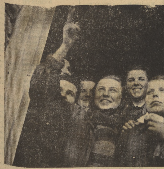
Z każdym dniem na warszawskich budowach pracuje coraz więcej kobiet. Kobiety złączają się w zawoźce, a na budowie nie ustępują w pracy mężczyznom. Na zdjęciu: brygada kobieca zatrudniona przy budowie przy ul. Włocław. Foto AR
