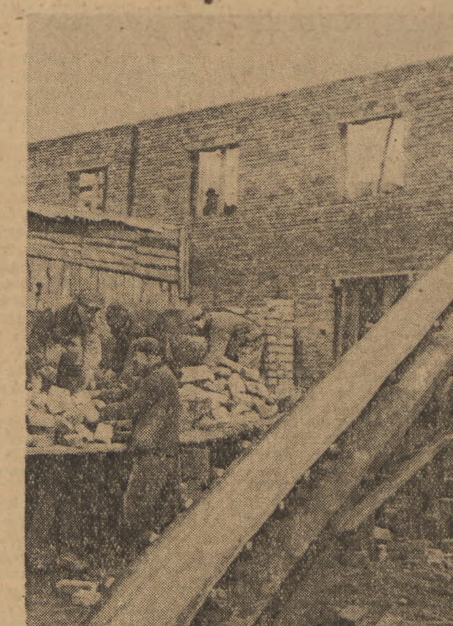
W szybkim tempie przebiegają prace przy budowie Marszałkowskiej Dzielnicy Mieszkaniowej. Wszystkie budowy MDM przyspieszają się do prowadzenia robót zimą. Na zdjęciu: zespół Przewoźnika Jasińskiego z bloku 6-b przy budowie pieca do ogrzewania żuraw. Foto AR
