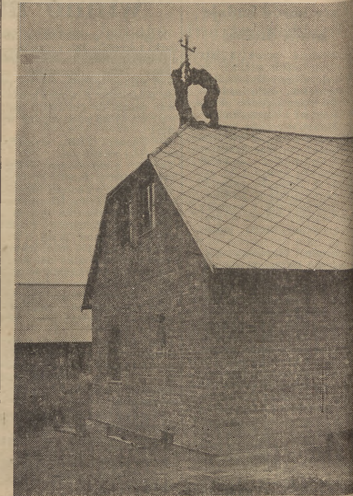
W dniu 26. VIII. br. zakończono roboty elektryfikacyjne i włączono do użytku prąd do spółdzielni produkcyjnej Czarnostów. Na zdjęciu monterzy PPB przy pracy.
