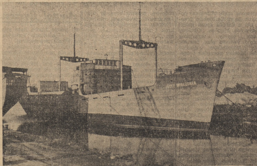
Szybko postępują prace nad wykończeniem wnętrza rudowęglowca S-S „Józef Wieczorek“.
