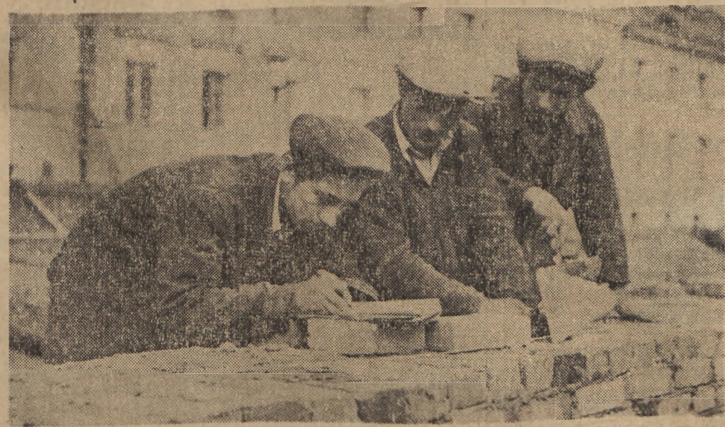
Murarze ZMP-owcy zatrudnieni przy budowie dzielnicowego domu towarowego na Martensztacie, podejmując wezwanie murarza tow. Stupeckiego, inicjatora nowej formy współzawodnictwa wśród budowlanych — dla uczczenia 33 rocznicy Wielkiej Rewolucji Październikowej i II Światowego Kongresu Pokoju — przystąpili do współzawodnictwa o tytuł najlepszego murarza w Polsce. Na zdjęciu: murarze Z. Leonarczyk, M. Zajar i R. Ciepielski podpisują zobowiązanie. Foto AB
