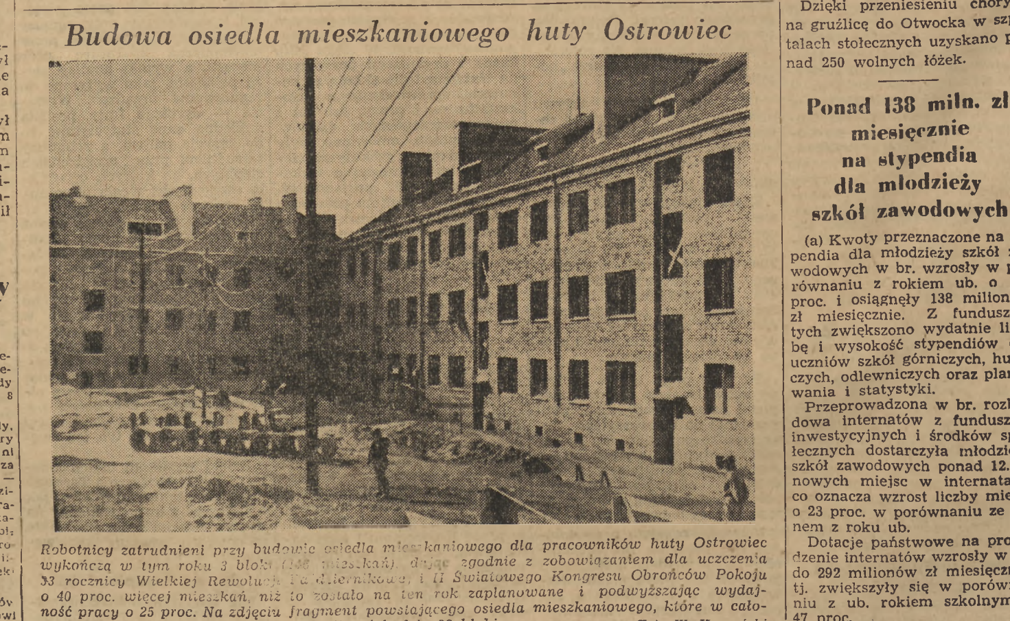
Robotnicy zatrudnieni przy budowie osiedla mieszkaniowego dla pracowników huty Ostrowiec wykonała w tym roku 3 bloki (136 mieszkań) dzięki zgodzie z zobowiązaniem dla uczczenia 33 rocznicy Wielkiej Rewolucji Październikowej i 41 Światowego Kongresu Obrońców Pokoju o 40 proc. więcej mieszkań, niż to zostało na ten rok zaplanowane i podwyższając wydajność pracy o 25 proc. Na zdjęciu fragment powstającego osiedla mieszkaniowego, które w całości liczyć będzie 32 bloki. Foto W. Kuczyński
