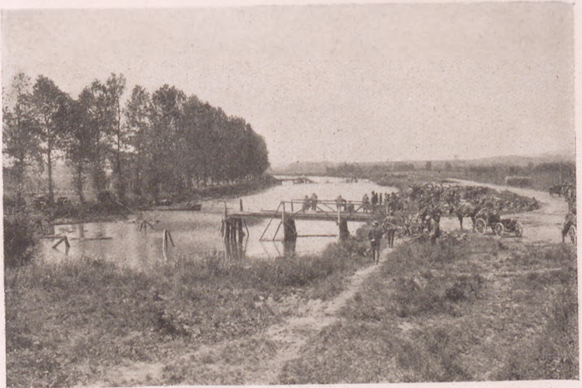
Bis zum Eintreffen von Brückenbaumaterial oder Brückentrains müssen die Truppen in Stähnen übergesetzt werden. (Zu dem Ponton sogar Pferde.)
