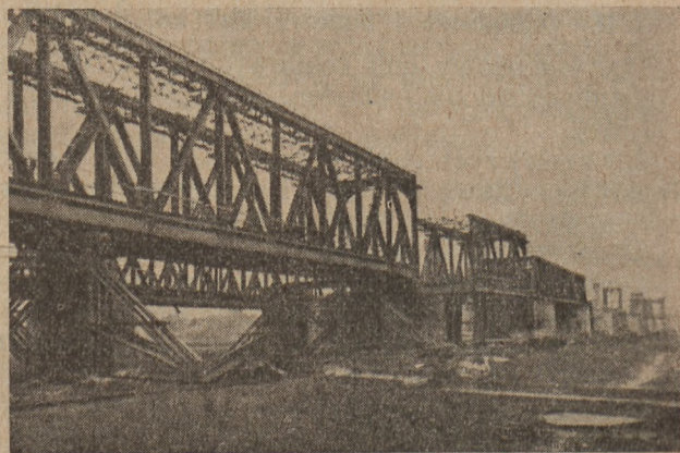
Rys. 4 Tczew — odbudowa mostu przez rz. Wisłę.
