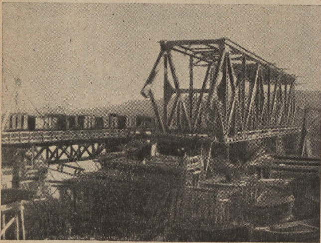
Rys. 6 Szczecin — Odra Wschodnia. Montaż przęsła.
