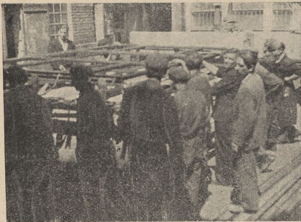
Konstrukcje stalowe ładuje się na przyczepę
