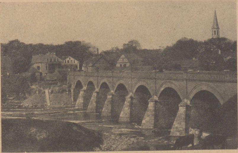
136. Goldingen: Brücke über die Windau
