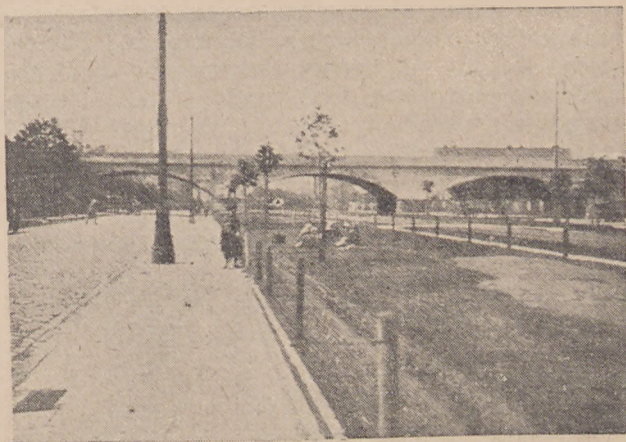
Wiadukt linii średnicowej nad ul. Targową
