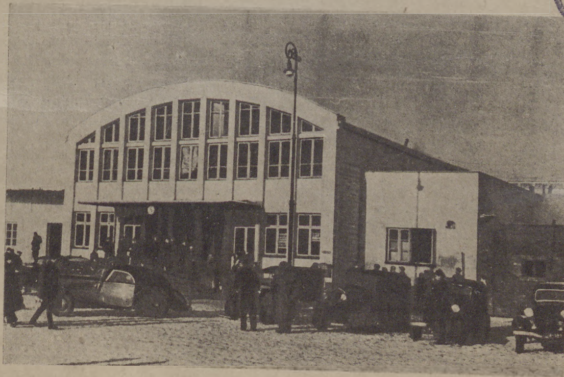
Wejście na prowizoryczny dworzec Warszawa Główna
