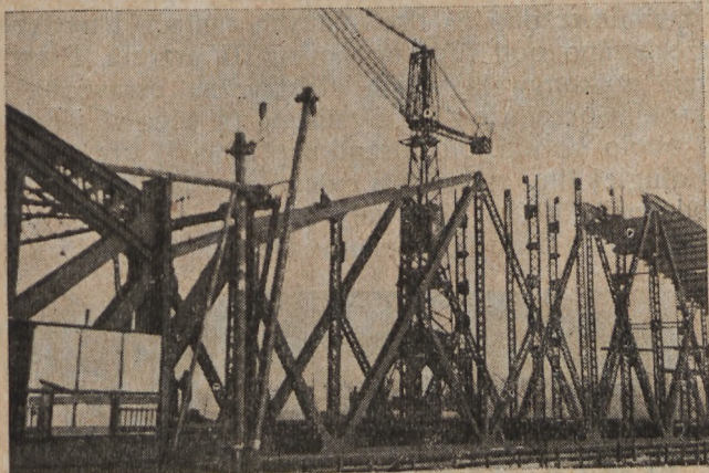
Rys. 12. Montaż III-go przęsła kranem Wolffa, składanie pasów górnych na drugiej połowie przęsła. Z przodu widać Derrick drewniany ustawiony na filarze dla podnoszenia zdemontowanych kratownic rusztowań z lodu na stare przęsło.
