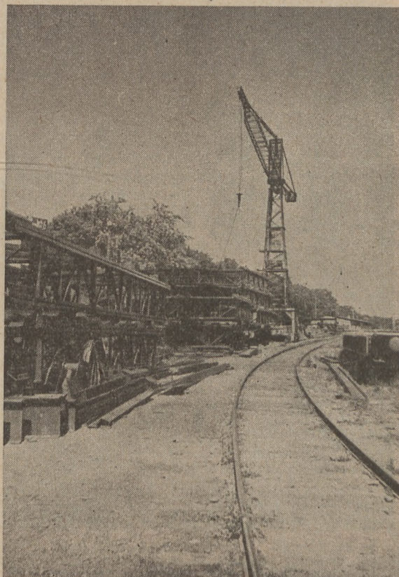
Rys. 6. Wyładowane kranem Wolffa kratownice rusztowań na placu składowym.
