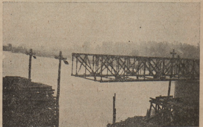
Rys. 9. Wysuwanie zmontowanych kratownic rusztowaniowych do II-go przęsła. Kratownice przed wejściem na jarzmo N 2. Maszty przy tym jarzmie służą do ciągnięcia kratownic.
