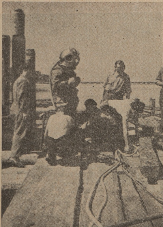
Rys. 2. Roboty nurkarskie przy biciu pali w I-ym prześle. Nurek przed zejściem do wody.
