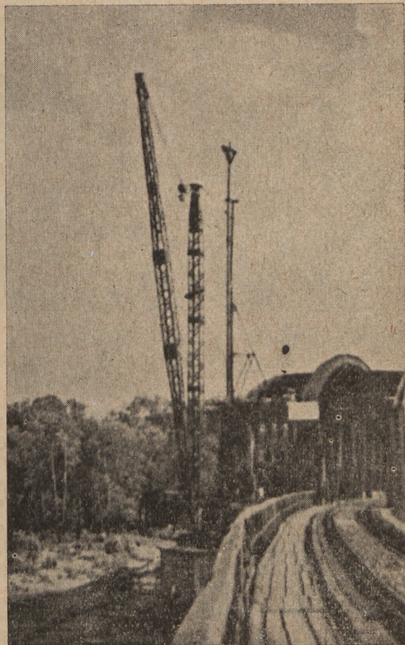
Rys. 7. Kran Derricka nośności 30 ton i wysięgu 30 m. po zmontowaniu na filarze.
