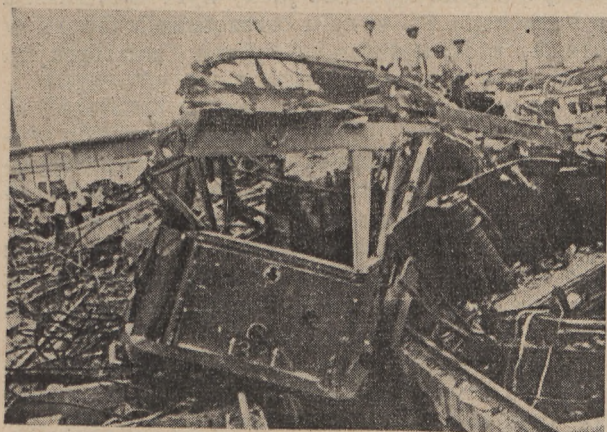
Wóz tramwajowy zniszczony
