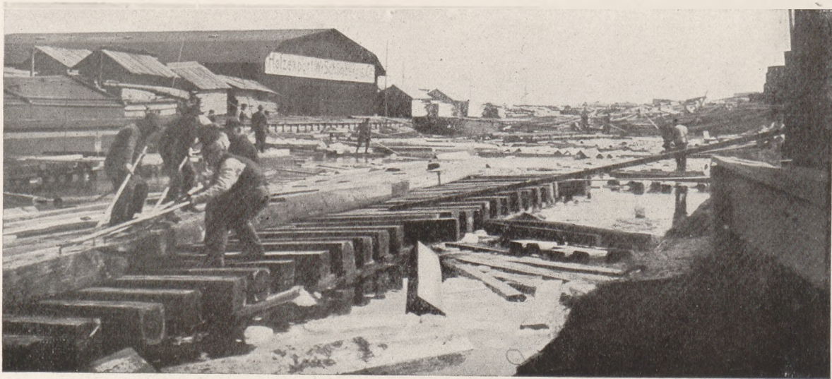
Entladestelle am Holm; breites Stichkanal mit Schuppen
