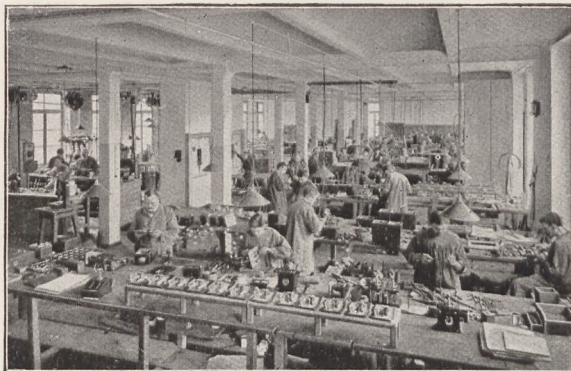
Montagesaal für Selbstanschlußapparate
