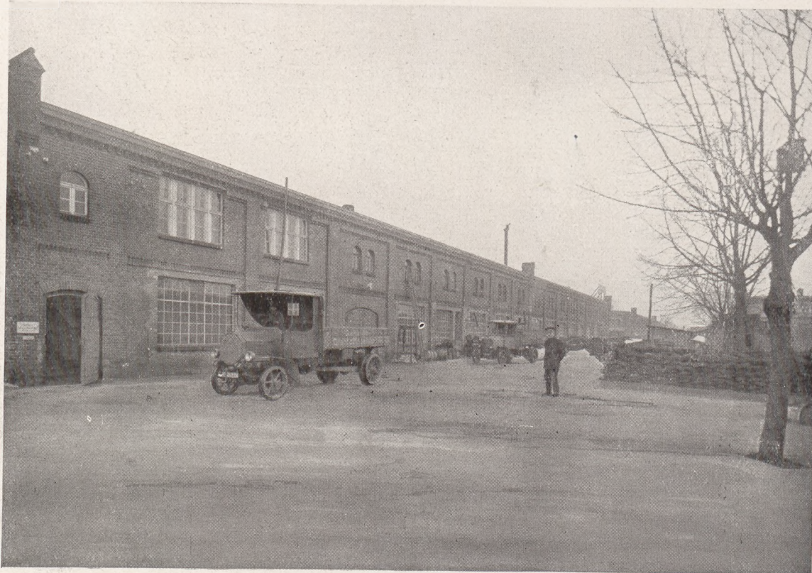
Danziger Draht- und Nagelfabrik A. G.: Gesamtansicht.
