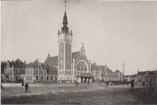
Hauptbahnhof Danzig (erbaut 1895-96)
