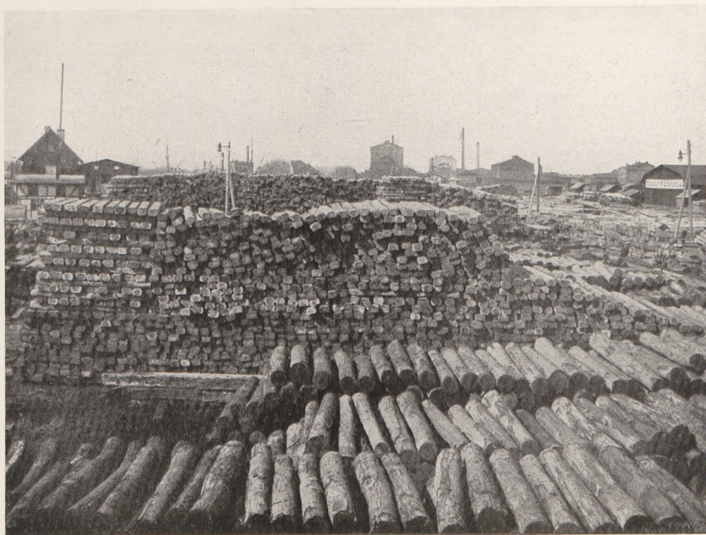
Schwellenlager auf dem Holmlagerplatz
