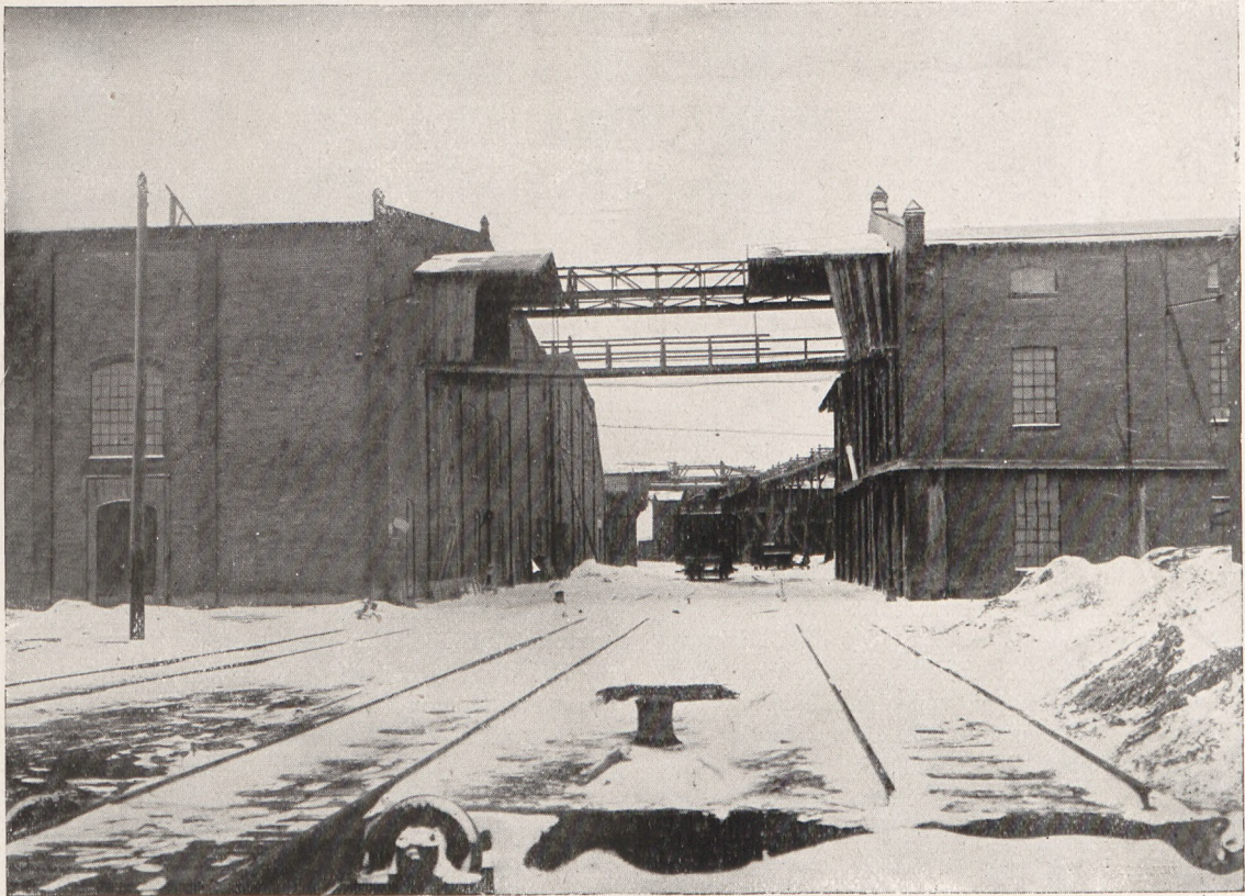
Rangierbahnhöfe und Lageräume
