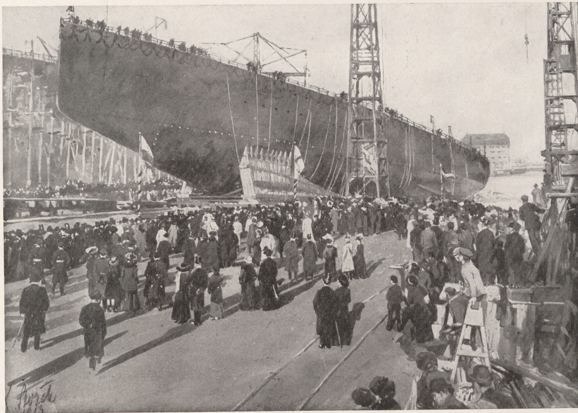
Stapellauf des Großen Kreuzers „Lützow“ (Geschwindigkeit: 30 Seemeilen; Maschinenkraft: 120 000 WPS) für die Deutsche Marine auf der Schichauwerft in Danzig am 29. November 1913
