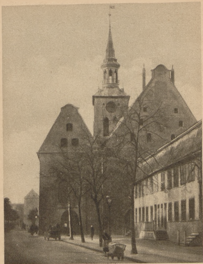
St. Barbara-Kirche auf Langgarten St. Barbara's Church on the Langgarten L'église Ste-Barbe à Langgarten
