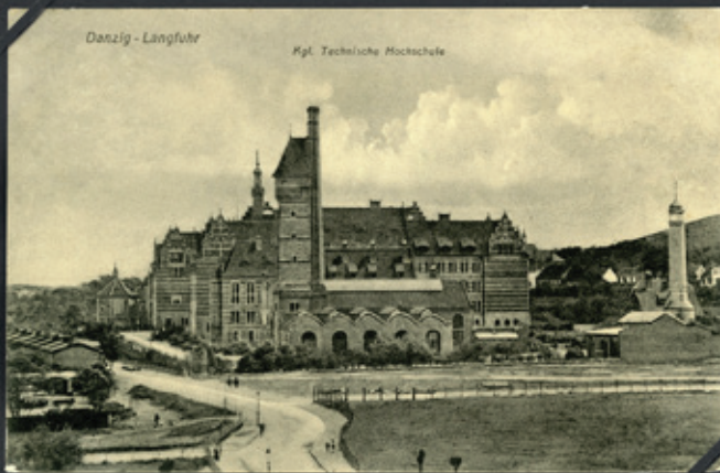
Na fotografii Laboratorium Maszynowe z kominem i wieżą ciśnień, widoczne od północnego zachodu (z Althoffweg, obecnie ul. Fiszera); na tle Instytutu Elektrotechnicznego i Gmachu Głównego. Z prawej strony: na największym węzle, na tle Gomu Mieszkaniowego głównego berkańska i pałacu znajduje się chłodnia kołniska. Z lewej strony strony Fundacji Abogaes przy Bröderweg (obecnie ul. Spaska). Pocztówka wydawnictwa W. S., Danzig z 1909 roku.
