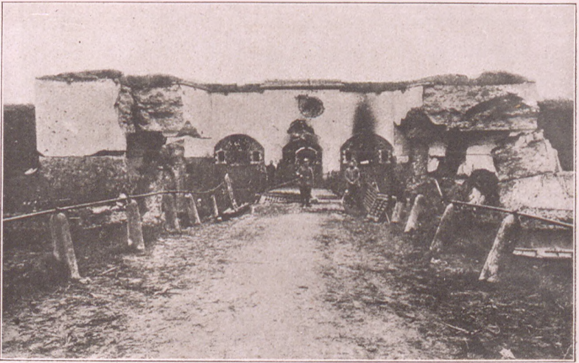
Fort Chemin de fer Der durch zwei Treffer zerstörte Eingang.
