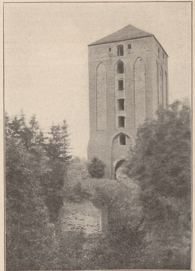
Torturm vom Ordenschloß Roggenhausen.
